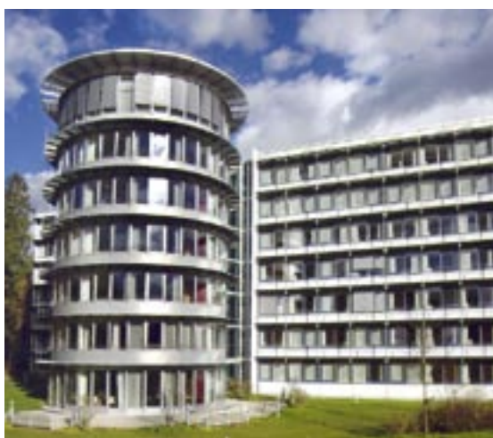
Verwaltungsgebäude der erweiterten und renovierten Klinik Höhenried
