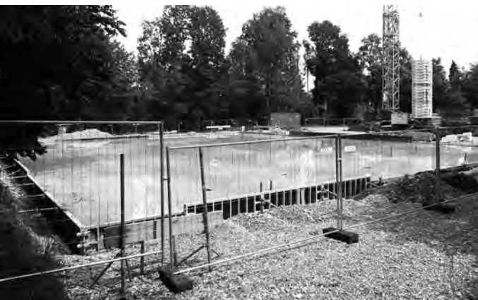
5. Juni: die Bodenplatte ist gegossen
