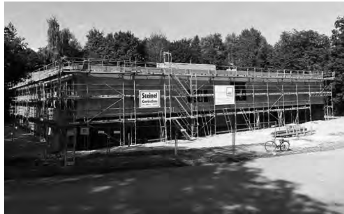
2. September: die Halle steht
