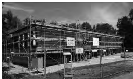
Rohbau der Sporthalle-Bernried
