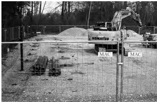
Mitte April: Bohrpfähle stützen das Fundament
