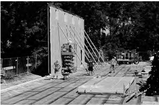
23. August: die Außenwände werden aufgestellt
