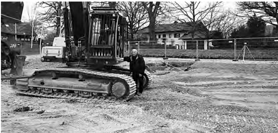
Beginn der Aushubarbeiten, festgehalten durch den 2. Vorstand Gerd Schramm
