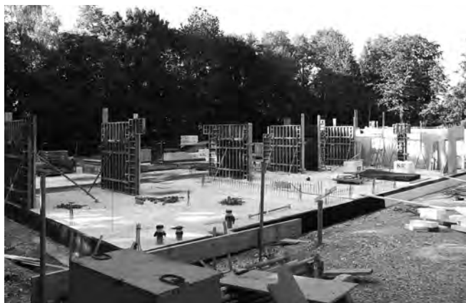
Anfang Juni: erste Wände werden betoniert
