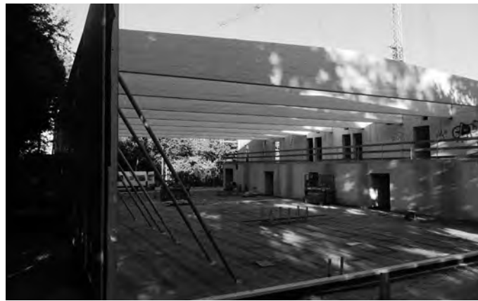
24. August: die Dachträger werden aufgesetzt
