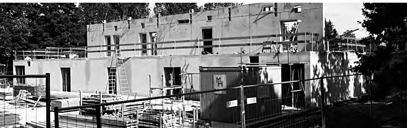
5. Juli: Sanitärtrakt und Umkleiden stehen
